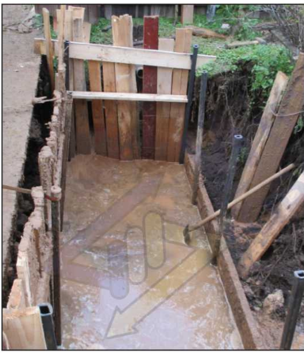
При обнаружении плавуна необходимо применение опалубки.
